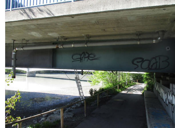
Bestandsentwässerungsleitung DN 150 inkl. Halterungen zurückbauen
